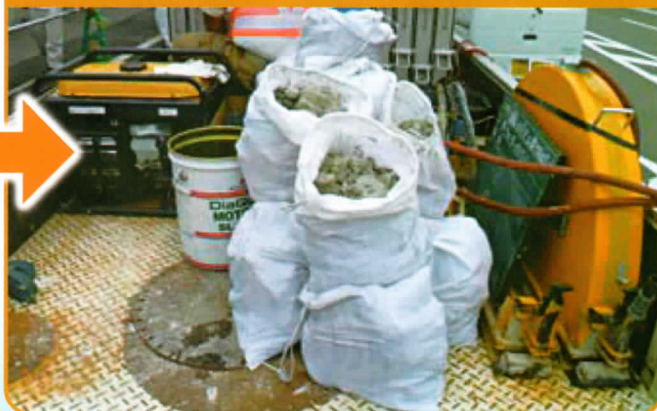
脱水ケーキ搬出・運搬
